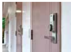
既存物件取付
